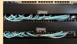
サーバー室内 スイッチとメディアコンバータ
